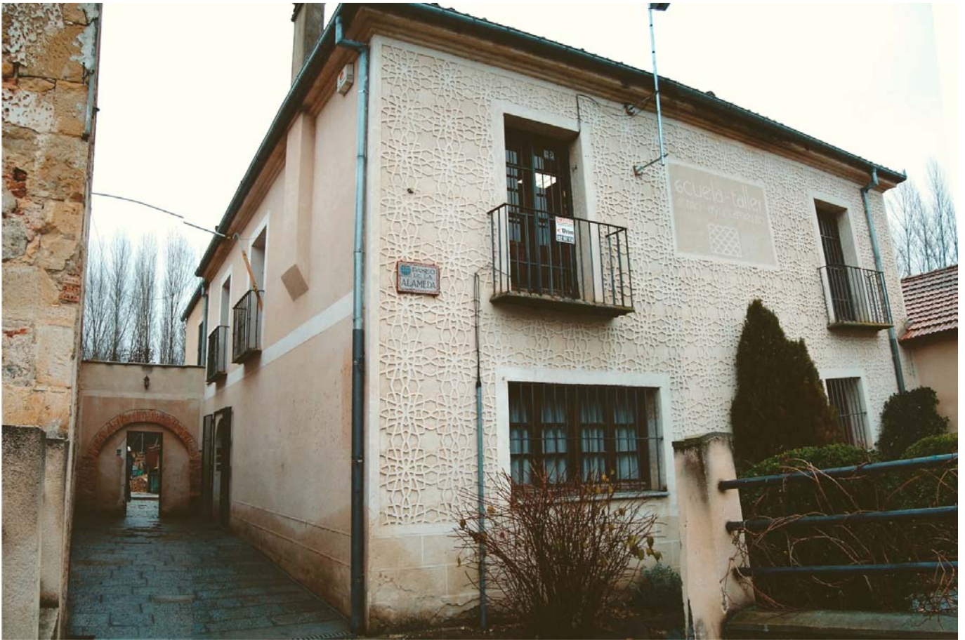
Foto 1. Fachada principal y lateral norte.
