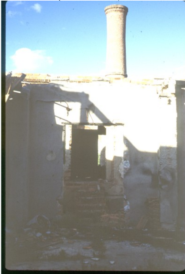
Vista de la edificación existente desde la entrada principal
