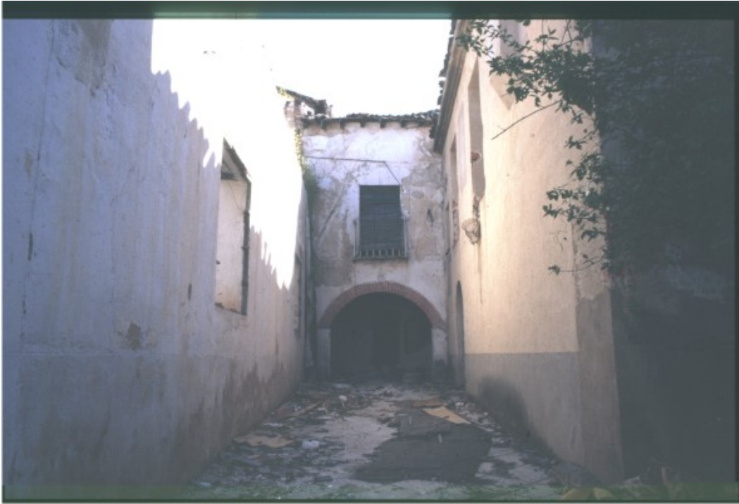
Vista de la edificación existente desde la entrada principal
