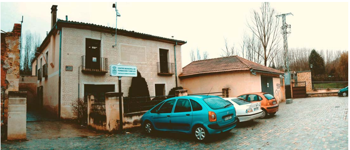
Foto 2. Fachada principal. Vista general. Cuarto de canteros.
