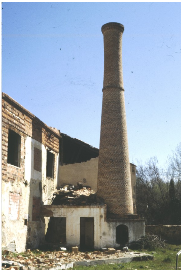
Edificación existente junto a la chimenea, posteriormente demolida
