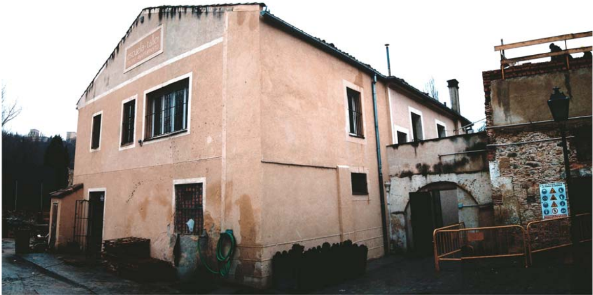
Foto 4. Fachada lateral sur (río). Vista general
